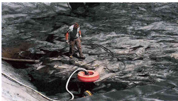
Inspection après nettoyage
